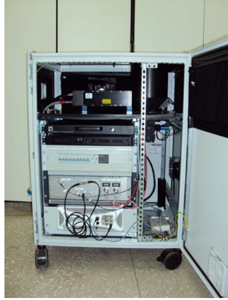
(b) Detalhe interno
